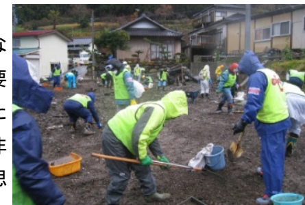
陸前高田にて瓦礫撤去作業
